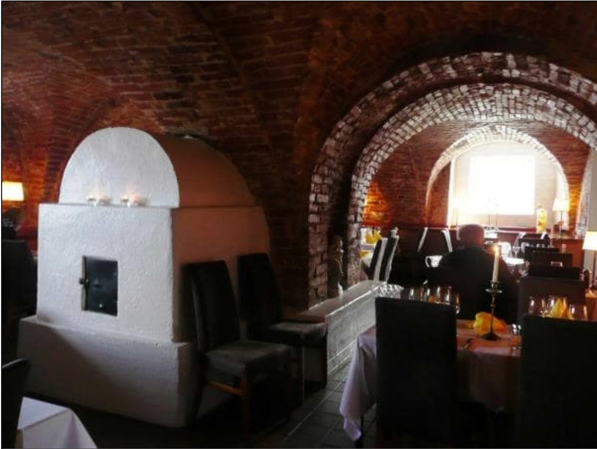
Yläkuvassa kellarin ravintolatilän tiiliholvausta. Oikealla kellarikerroksen tiililattiaa.
